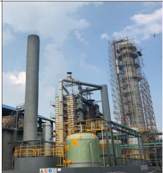
回转窑焙烧烟气“布袋除尘器+风机+25m 排气筒”
