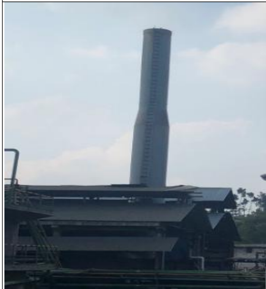
熔化炉烟气“换热+旋风+旋流板塔除尘+32m 排气筒（碱液吸收）”
